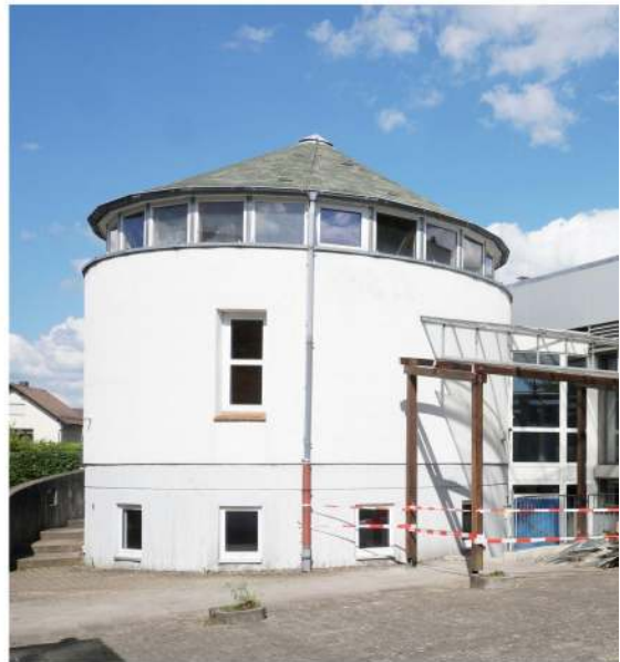
Noch stehen sie: Vorbereitende Abrissarbeiten
